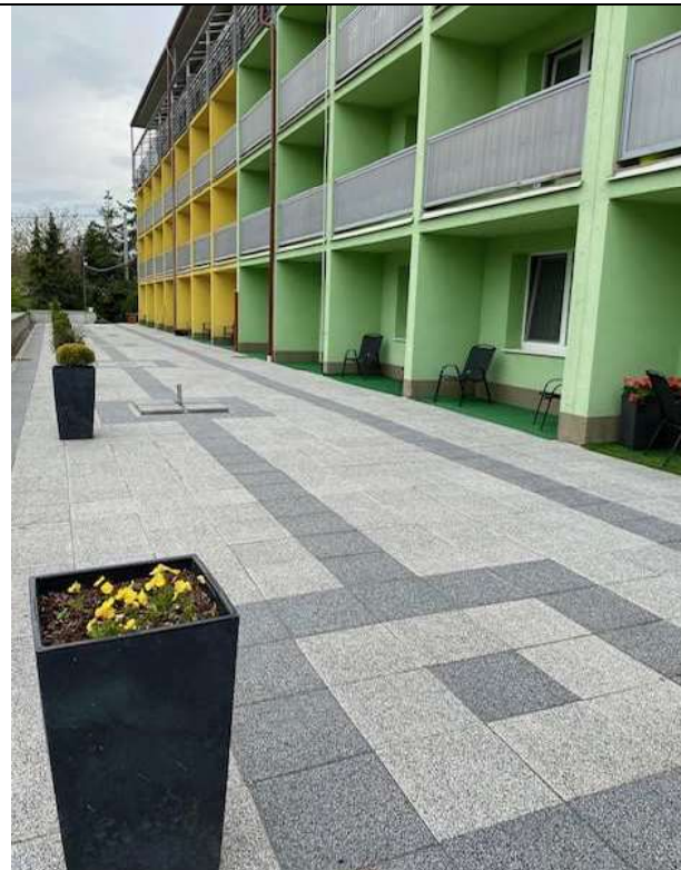
Oprava oporného múra na terase
