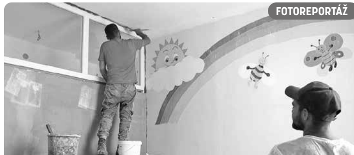
Začala rekonštrukcia priestorov Materskej školy na Stolárskej ulici. Mesto na ňu získalo finančné prostriedky z IROP vo výške 309-tis. eur, z ktorých v škole pribudnú nové steny, dvere, toalety, podlahy, klimatizačné jednotky, vzduchotechnika v kuchyni a terasy. Takisto sa zmodernizuje tunajšia trieda pre deti s autizmom. Mesto prispeje na rekonštrukciu 5-mi percentami celkových nákladov.
