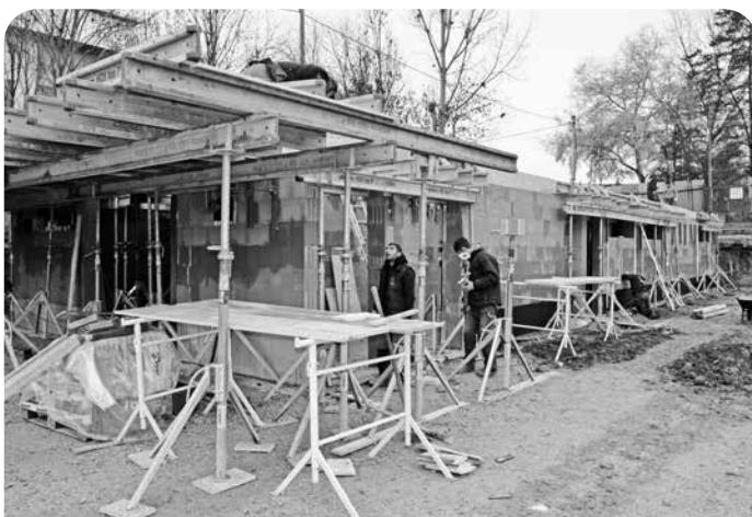
V súčasnosti sa dokončuje 2. nadzemné podlažie tréningového centra na atletickom štadióne. Do konca roka plánujeme stavbu uzavrieff - dokončiť strechu a založiť okná. Počas zimných mesiacov sa budú realizovať všetky práce spojené s vnútornými rozvodmi elektriny, vody a odpadu.
