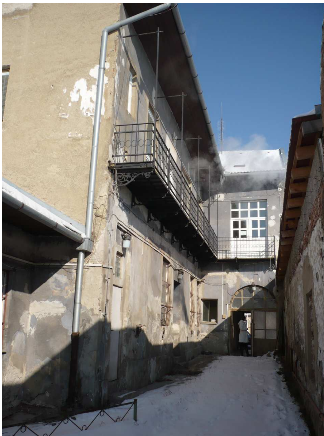
Dvorová časť predného traktu objektu Zimná č. 72 (v smere k Zimnej ulici)
