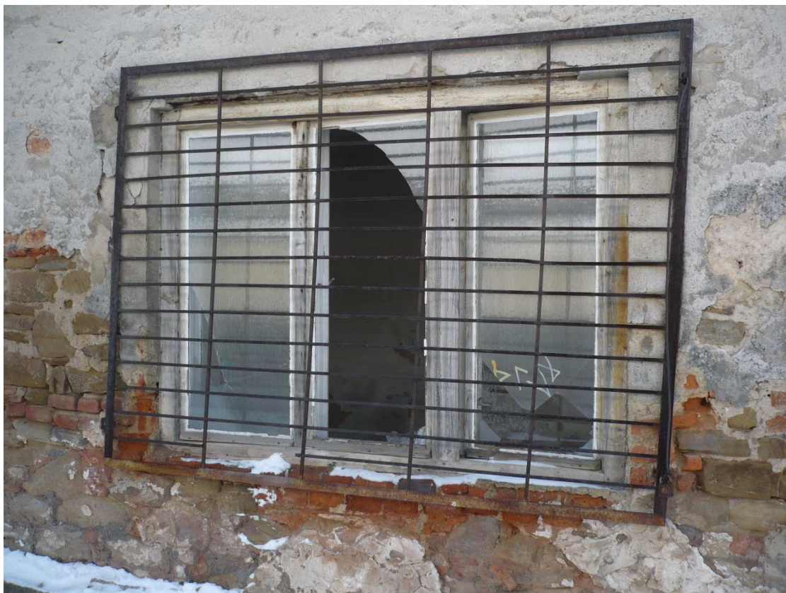
Detail prízemnej časti budovy Zimná č. 71 orientovanej do Škultétyho ulice
