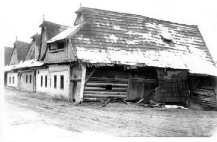
Ľudový dom spišských Nemcov so strechou na samostatnej stĺpkovej konštrukcii a s galériou v rozlomenom štíte ukončeným kabrincom a makovicou
