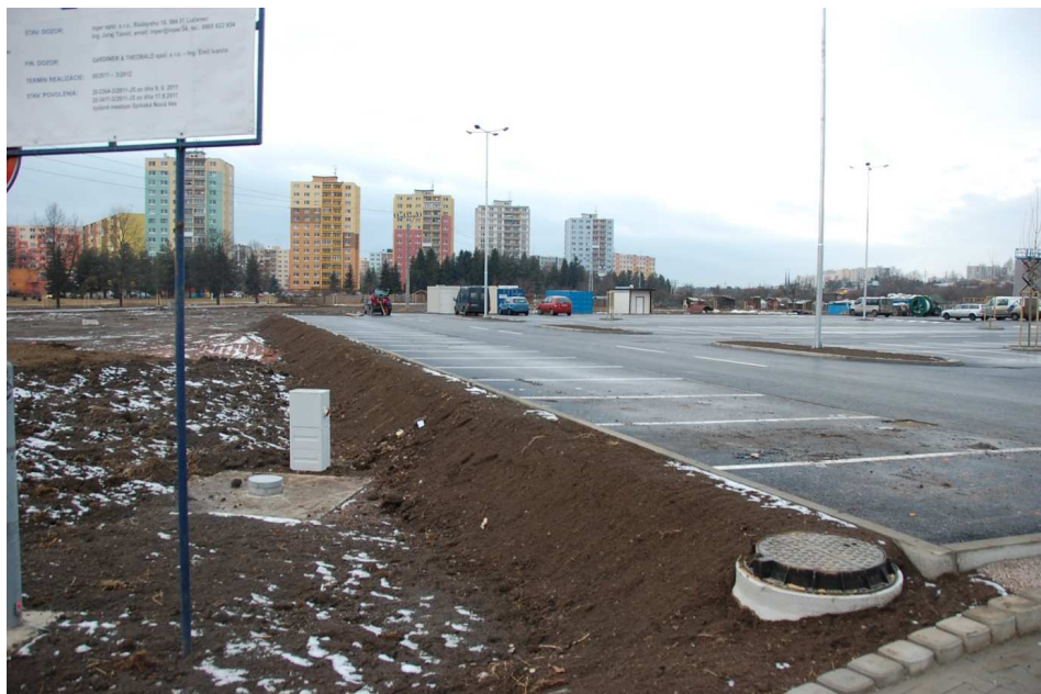
Foto: Novovybudované plne nepriepustné parkovisko pri nákupnom stredisku s odkanalizovanou dažďovou vodou
