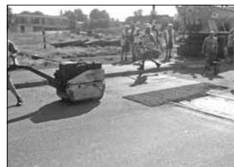
Asanácia železničnej vlečky, Mlynská ul.
