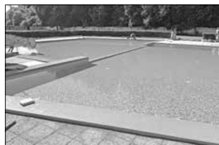
Fóliovanie bazénov na letnom kúpalisku
