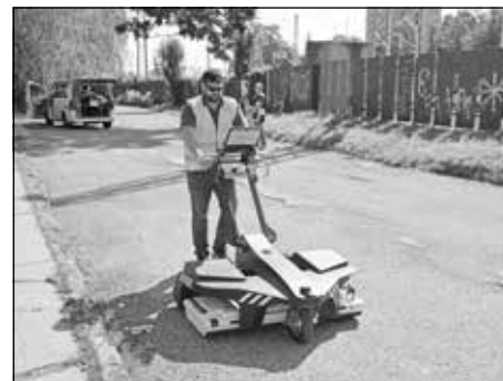
Hĺbková diagnostika predpätých mostov a lávok
