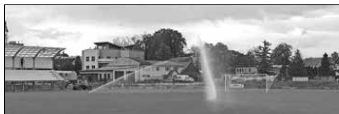
Vybudovanie automatického zavlažovacieho systému hlavnej hracej plochy
