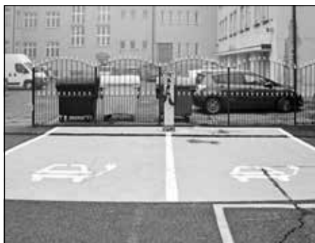
Výstavba nabíjacej stanice pre elektromobily
