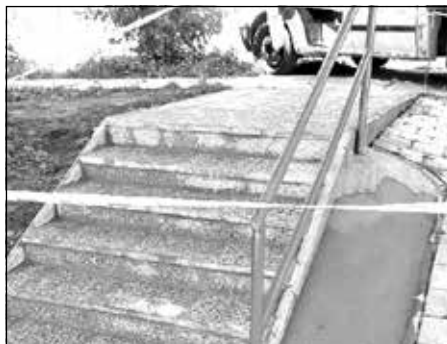
Oprava schodiska, Mlynská ul.
