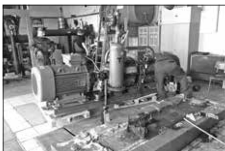
Rekonštrukcia technológie chladenia
