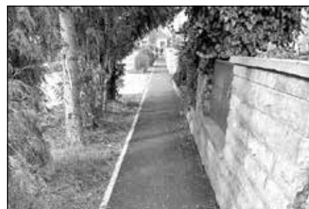
Výmena obrubníkov, Stojan
