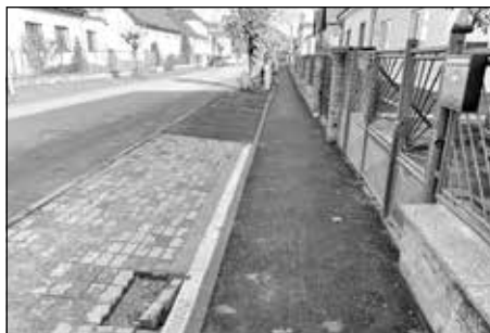
Oprava chodníka, Zvonárska ul.
