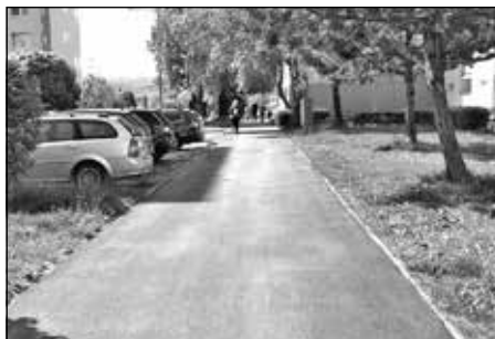
Rekonštrukcia chodníka, Tkáčska ul.
