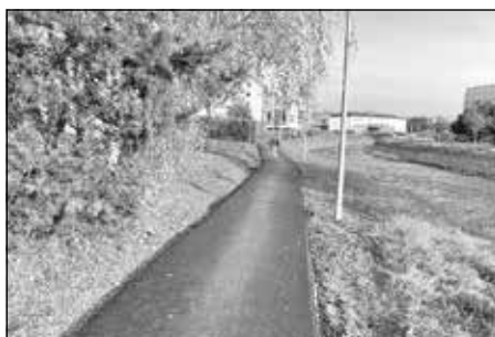
Oprava chodníka, Nábřežie Hornádu
