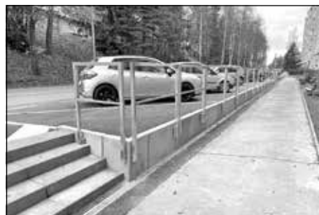
Stavebné úpravy parkoviska a chodníka, Ul. J. Wolkeru 25 - 31
