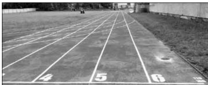
Oprava povrchu atletickej dráhy v areáli ZŠ Lipová
