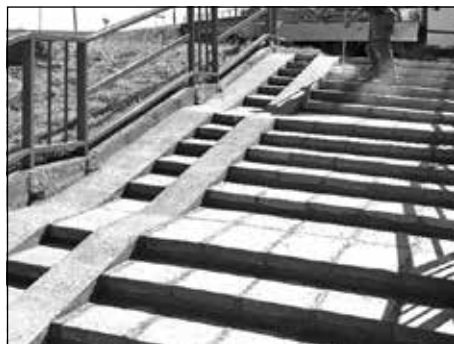
Oprava schodov, Radlinského ul.
