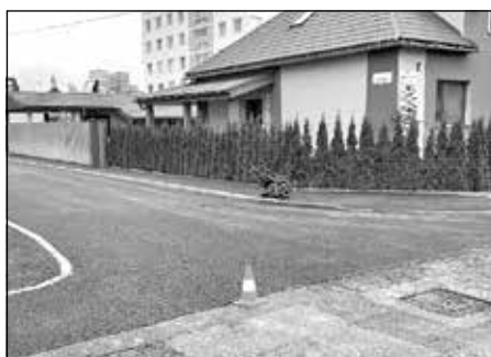
Oprava komunikácie a chodníkov, Ul. T. Vansovej
