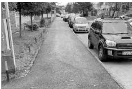
Oprava chodníka, Kolárska ul.
