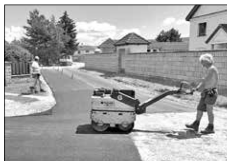
Asfaltová oprava časti komunikácie, Drevárska ul.
