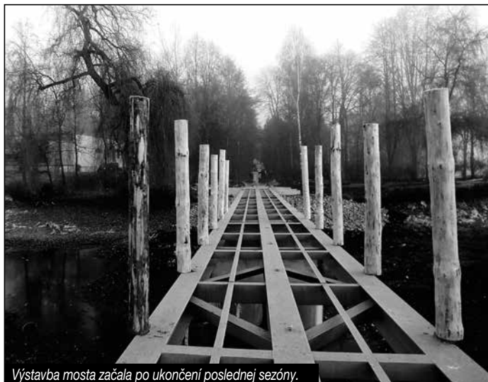
Výstavba mosta začala po ukončení poslednej sezóny.
