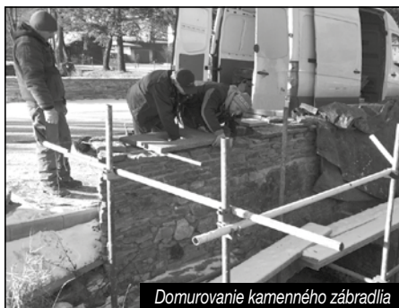
Domurovanie kamenného zábradlia
