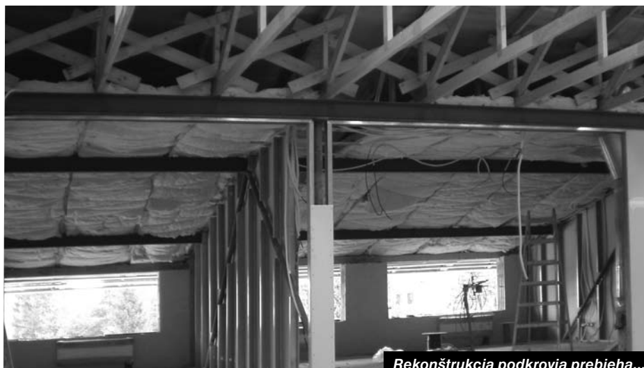
Rekonštrukcia podkrovia prebieha...
