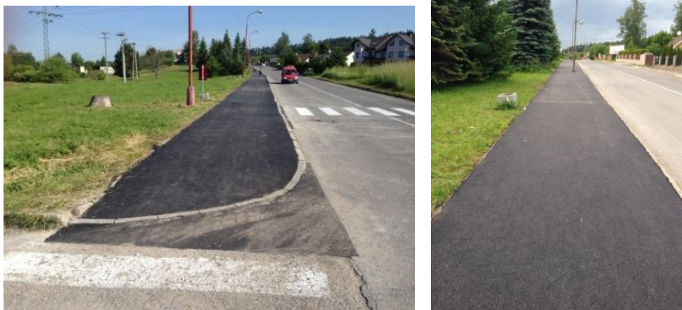
Obr. 2 Chodník na ul. Jánskeho
