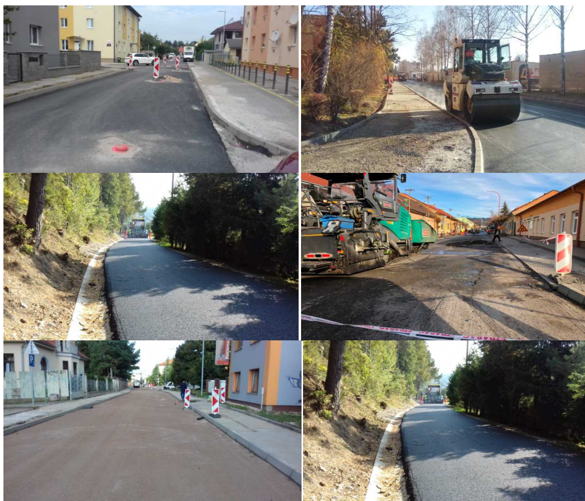
Obrázok č. 25 Fotodokumentácia rekonštrukcie miestnych komunikácií 2017 - 2018
