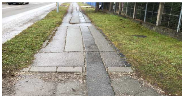
Obrázok č. 32 Fotodokumentácia existujúceho stavu objektov
