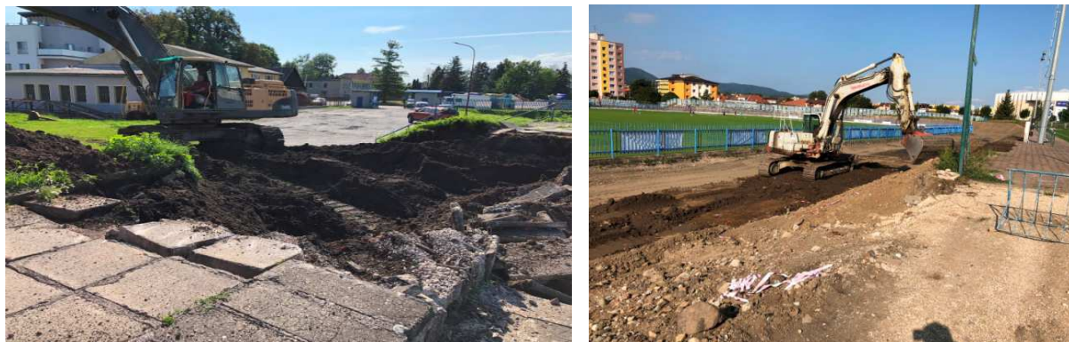
Obrázok č. 29 Fotodokumentácia športovísk – búranie tribúny futbalového štadiónu
