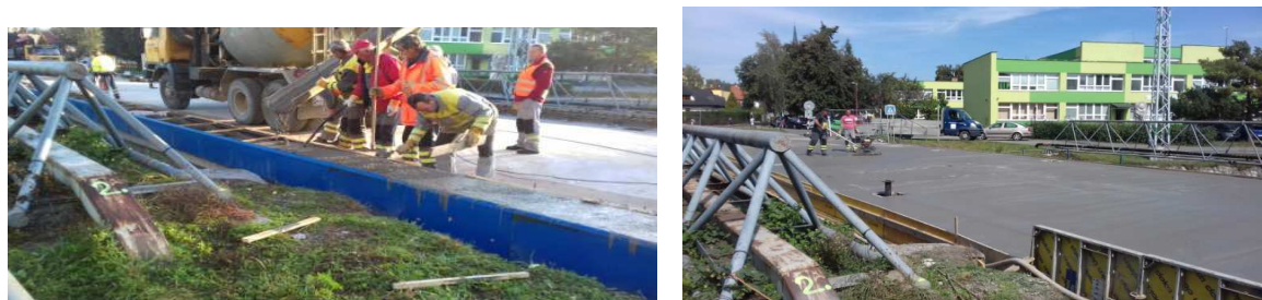
Obrázok č. 27 Fotodokumentácia rekonštrukcie mostu na ul. Ing. O. Kožucha
