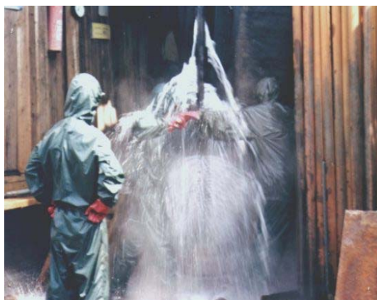
Vrt PP-1 po navrtaní termálnej vody
