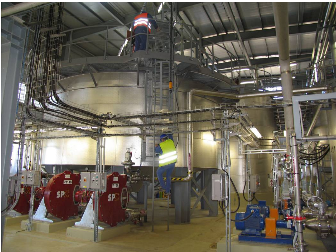
Obr. č. 2 Technologie NDS ML, zahušťovanie suspenzie v Dorrově usazovaku
